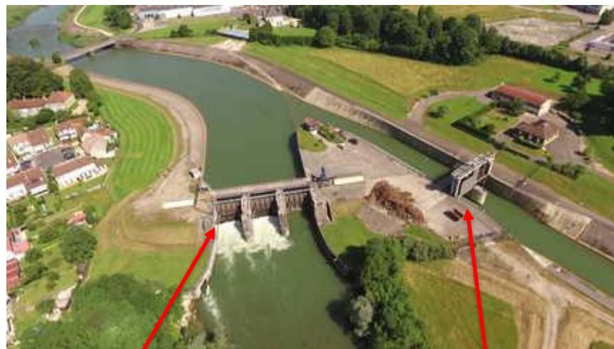
Barrage avec vannes de réglage
