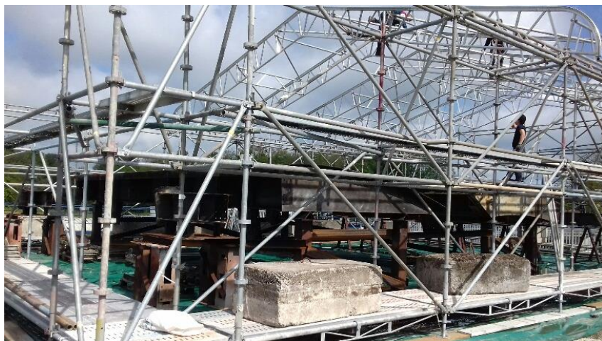
Vannes de réglage sous le chapiteau
