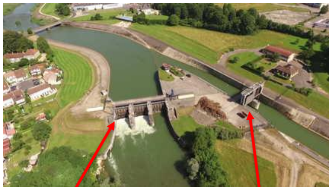
Barrage avec vannes de réglage
