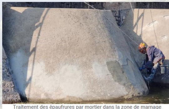
Traitement des épaufrures par mortier dans la zone de marnage
