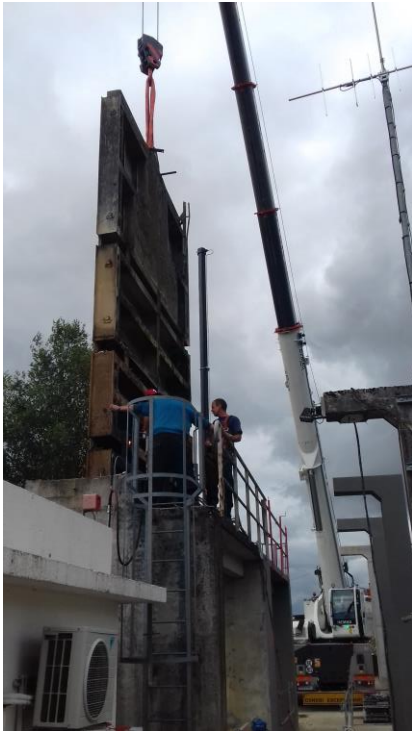
Dépose de la vanne droite
