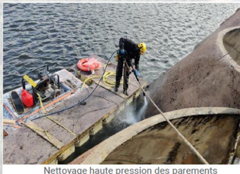
Nettoyage haute pression des parements
