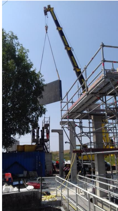
Repose de la vanne gauche
