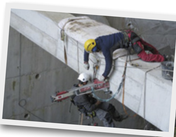
Contrôle des butons, barrage de Pannecièrre
