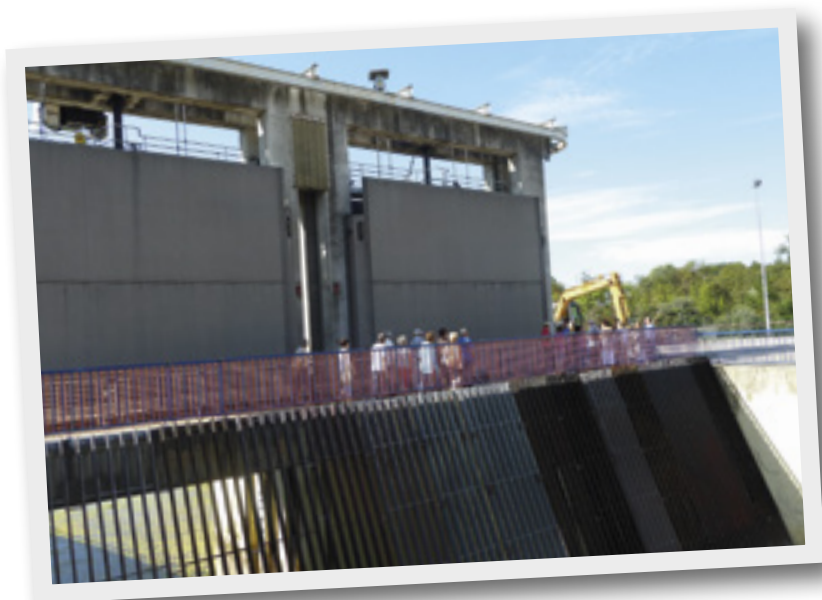
Journées européennes du patrimoine, prise d'eau Marne
