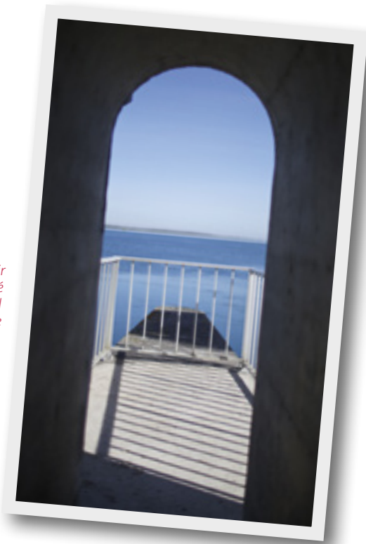
Déversoir d'extrémité du canal d'aménée Seine
