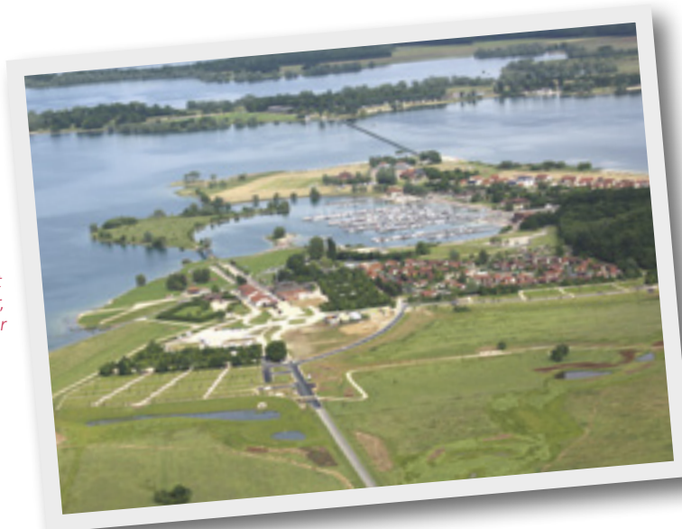
Port de Giffaumont et digue de Rougemer, Lac du Der
