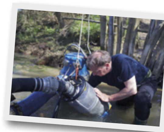
Entretien du siphon de la Boderonne, lac Seine
