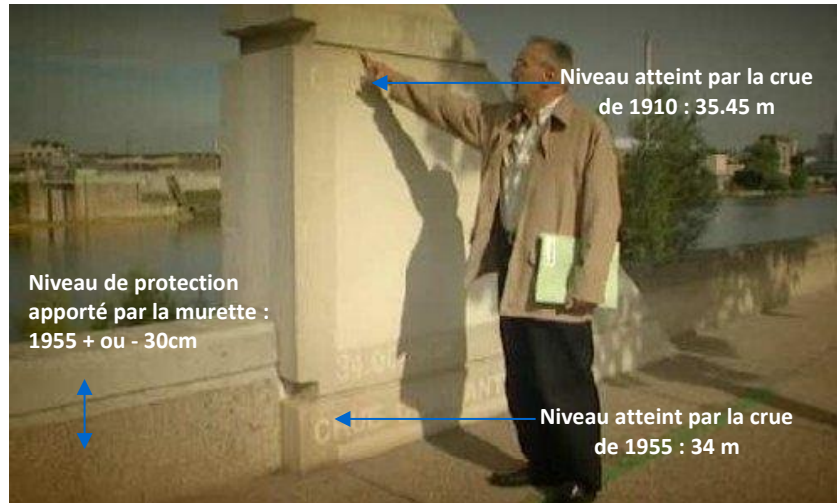
Figure 19 : Murette anti-crues, quai Jules Guesde, Vitry Sur Seine (94). Source : EPTB Seine Grands Lacs
