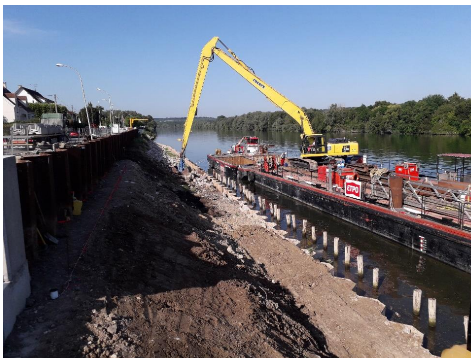
Figure 48 : Travaux sur la digue de Sartrouville à Montesson (source : SMSO)
