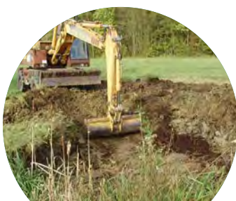
PENDANT LES TRAVAUX
