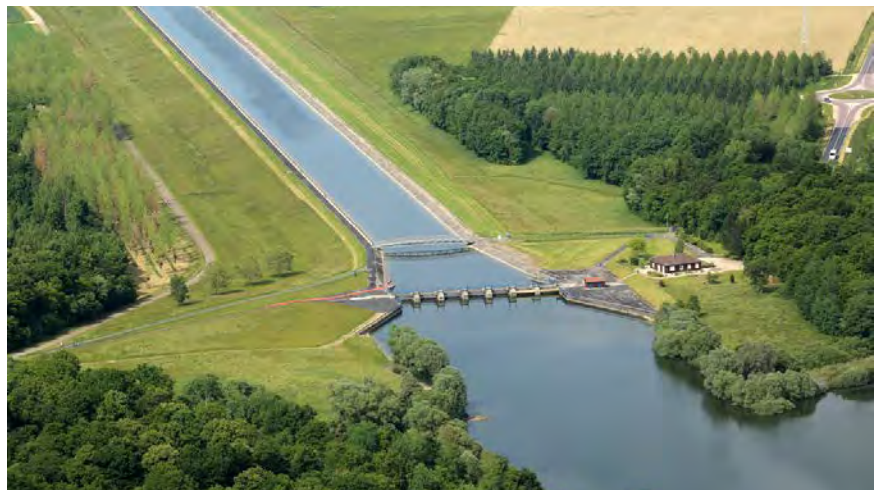
Déversoir d'extrémité du canal d'aménée Marne
