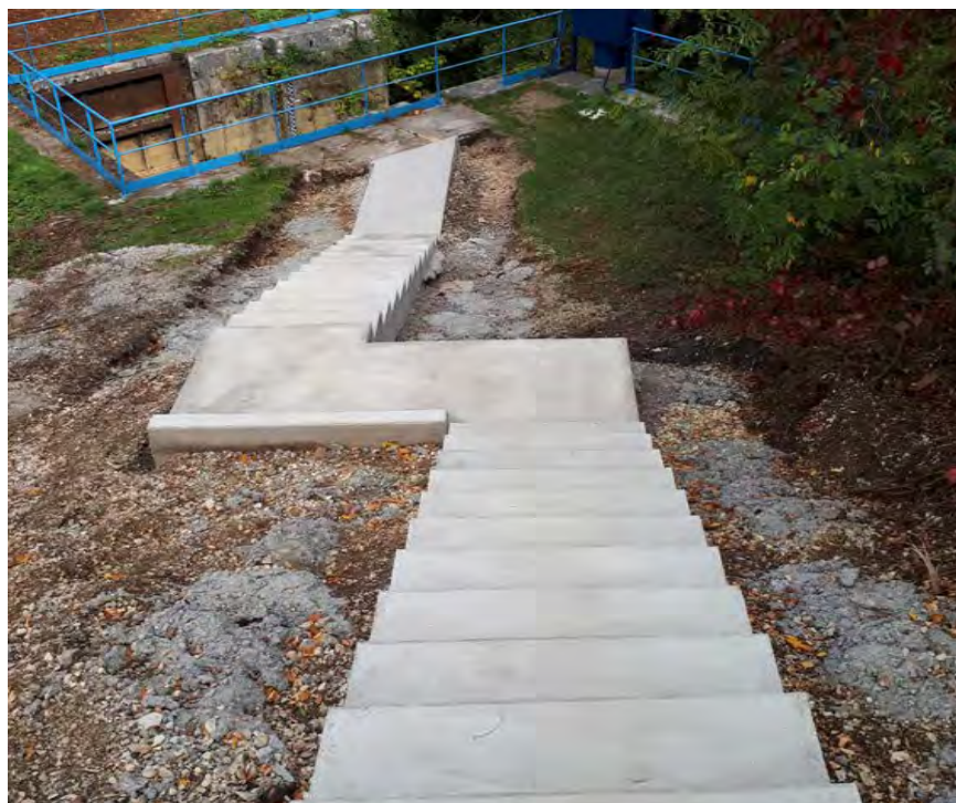
Aménagement d'un escalier d'accès à la Marne à Saint Dizier (52)
