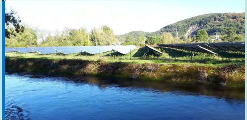
Champ terrestre de panneaux photovoltaïques
