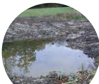
JUSTE APRÈS LES TRAVAUX
