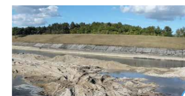
Prise d'eau de Courtenot le 24/09/2018 – Travaux d'extraction en cours
