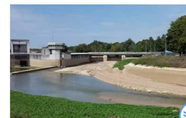
Prise d'eau de Jessains le 31/08/2018 – Passage à gué réalisé (à droite de l'image), début de l'extraction des sédiments
