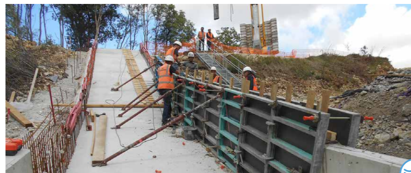
Construction du coursier pour l'exutoire du ru du Val
