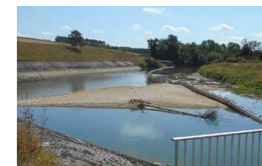
Avant travaux – Prise d'eau Seine
