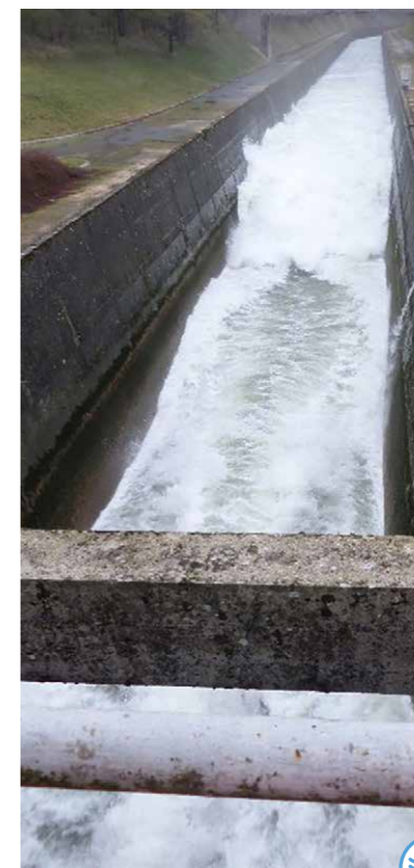
Canal d'aménée Seine – aval immédiat de l'ouvrage de réglage des débits de prise
