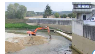
Prise d'eau de Jessains le 5/09/2018 – Curage en cours
