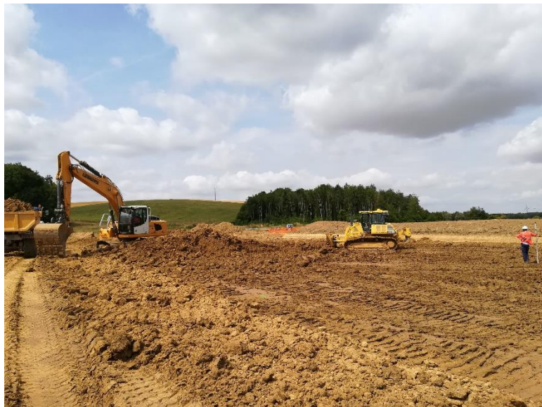
Décapage des terrains
