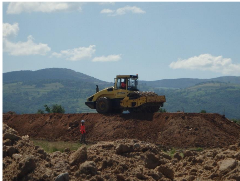
Compactage de la digue
