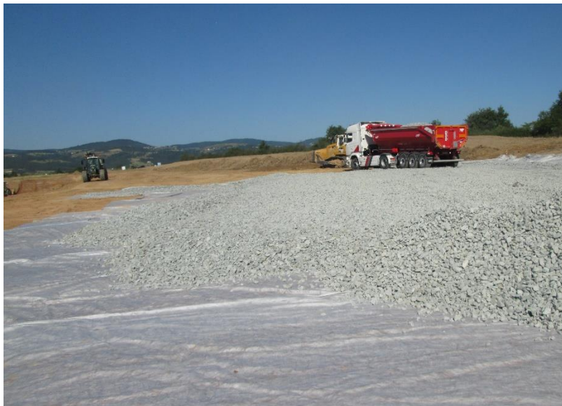
Livraison de matériaux
