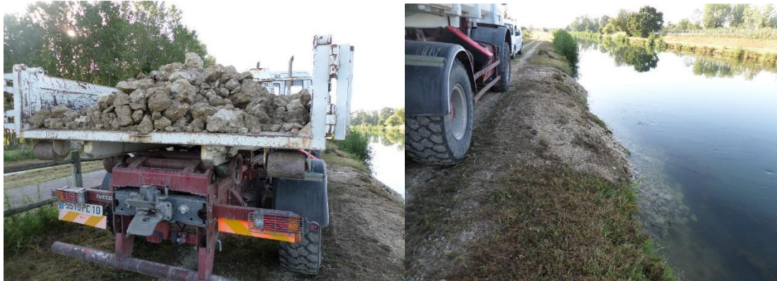
Confortement réalisé avec des enrochements afin de stabiliser la berge du canal de restitution Seine
