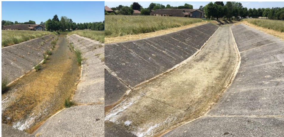
Nettoyage du canal de restitution d'Amance (lac Aube)
