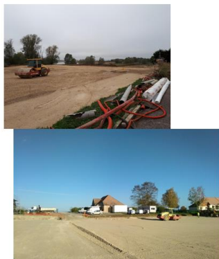
Préparation de la plate-forme (novembre 2022)
