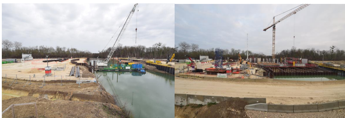
Avant/après (début 2023 – fin 2023) : évolution entre janvier et décembre 2023 du chantier de la station de pompage
