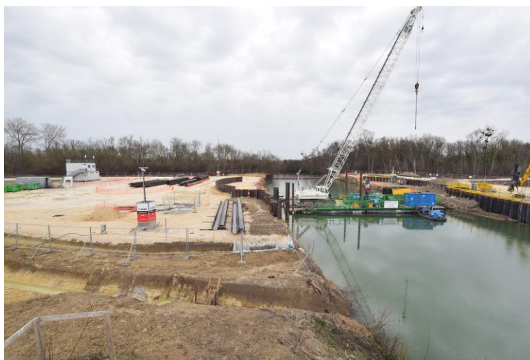
Travaux de terrassements et de création de l'écran étanche du tronçon Ouest de la digue
