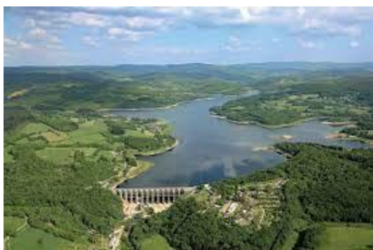
Lac-réservoir de la Pannecièrre Superficie de 520 hectares Capacité de 80 M. de m 3
