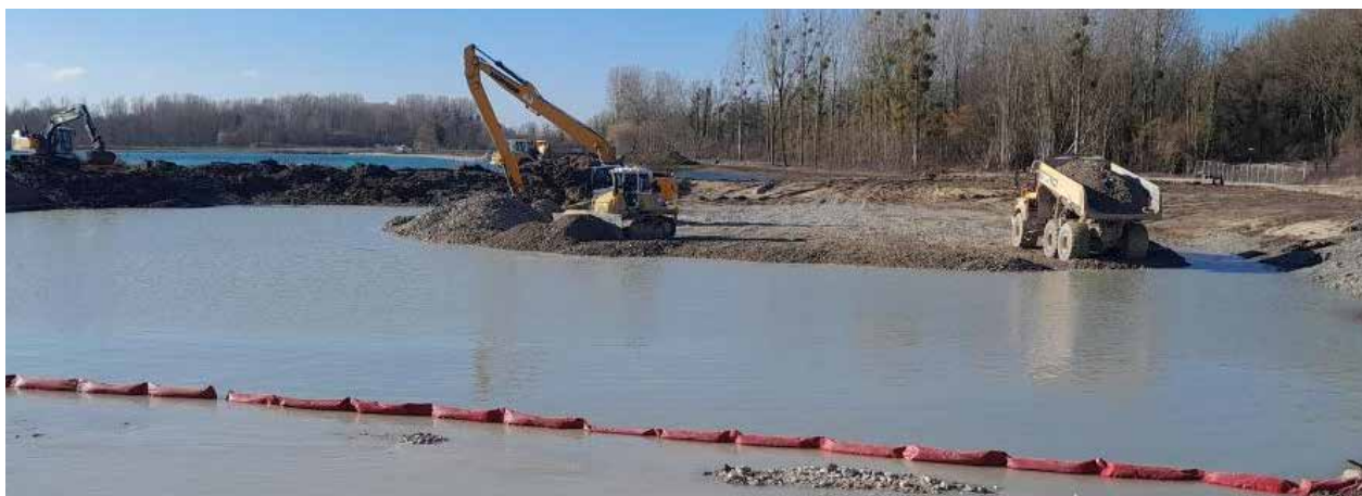
Travaux de remblaiement sous protection de filet anti-MES - Janvier 2023.
