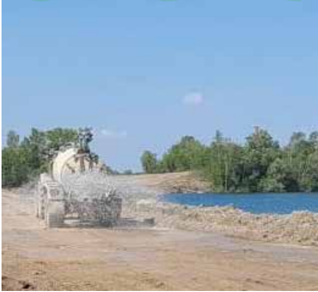
Arrosage des pistes du chantier pour éviter la dispersion des poussières - Avril 2023.
