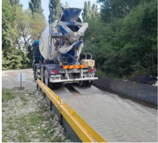
Lavage des roues des engins de chantier pour éviter la dissémination des espèces exotiques envahissantes - Juin 2023
