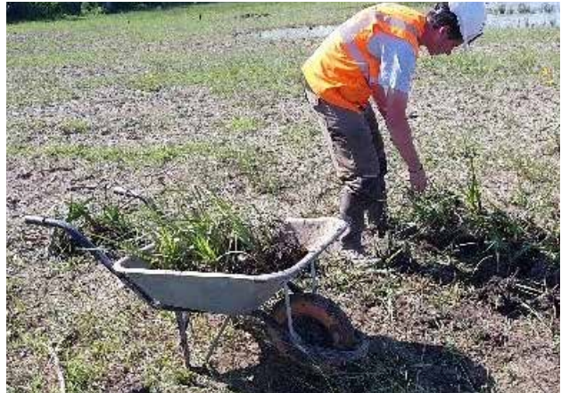
Travaux de plantation d'hélrophytes.
