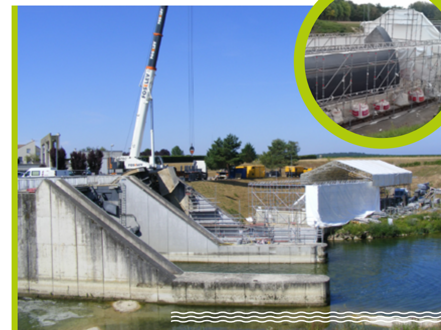
Barrage en rivière Aube Vue aval du génie civil du barrage et de l'édifice provisoire dédié au désamiantage de la vanne rénovée ©Seine-Grands-Lacs
