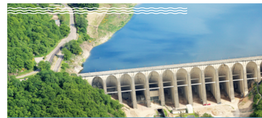
Barrage de Pannecièrre : Vue aval du barrage ©Seine-Grands-Lacs
